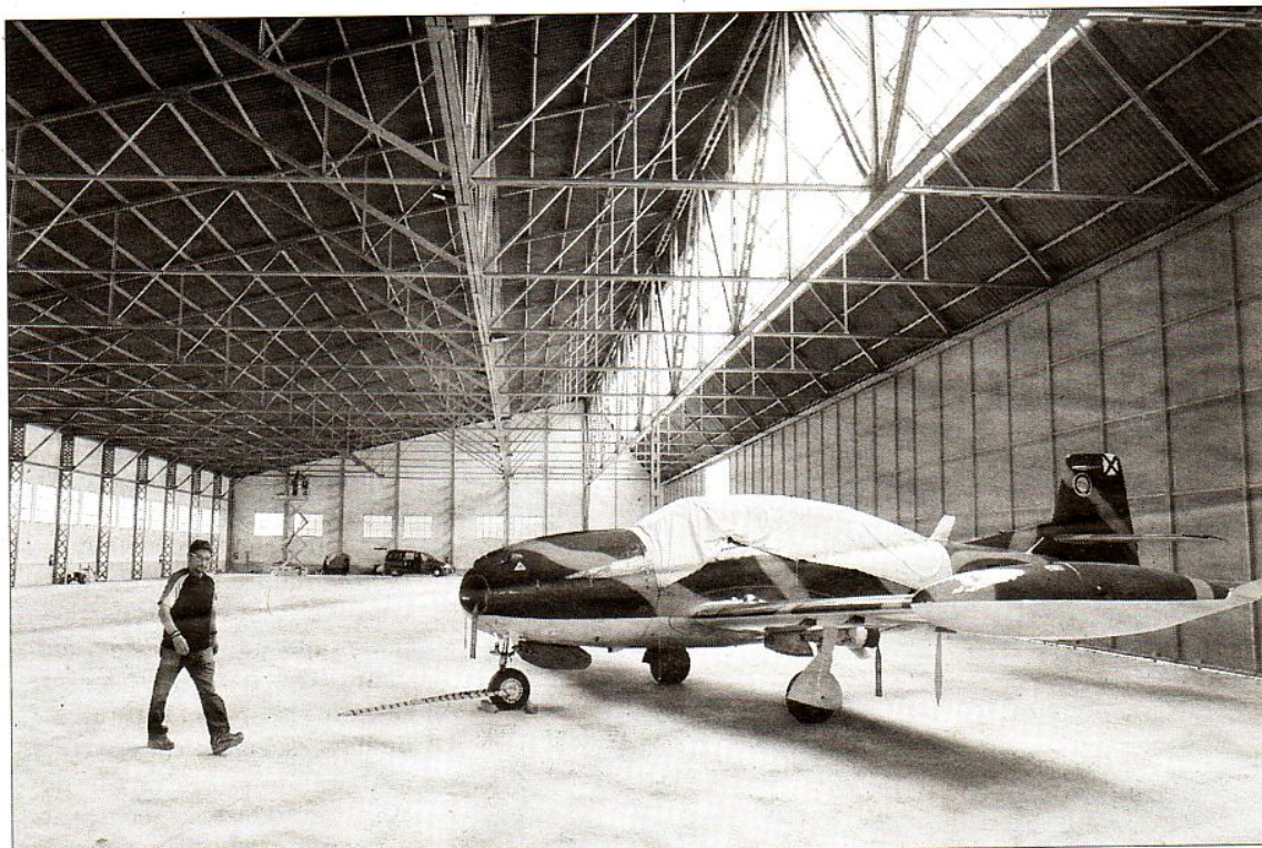
▶ Aspecto que ofrecía ayer el reconstruido hangar militar en el Aeroclub. FOTO: PERE FERRÉ
